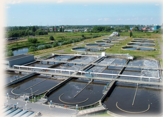
Imagen: Estación depuradora de aguas residuales. Fuente: Annabel.
